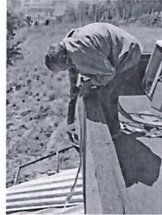
Cambio de mangueras que conectan el compresor con el mini split
