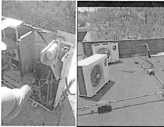
Se desconectó y se retiró equipo compresor dañado, al igual que las ducterías
